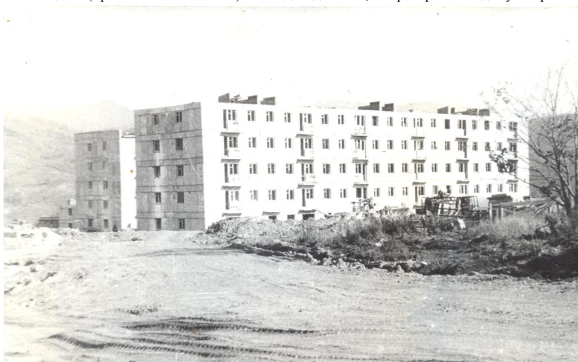
Дома по улице Первостроителей №№ 5,4,3
