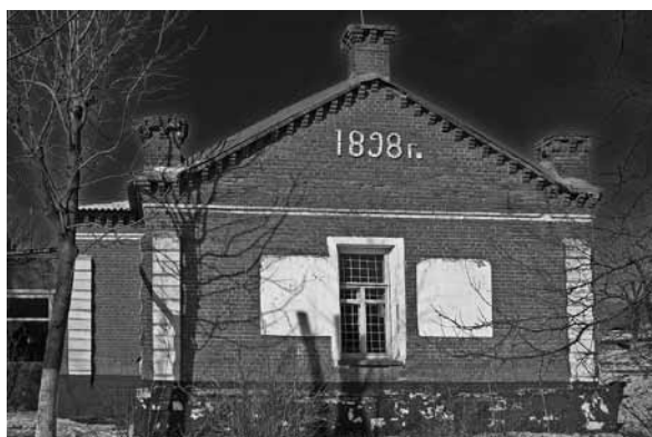
Раздольное, воинское здание постройки 1898 г.
